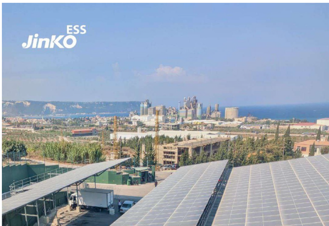
图11：厂区内的车棚光伏电站，背景为 Chekka 海岸线
